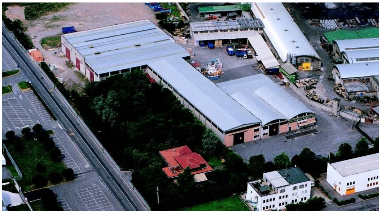
Fig. 2.1 – Fotografia aerea dell'impianto
