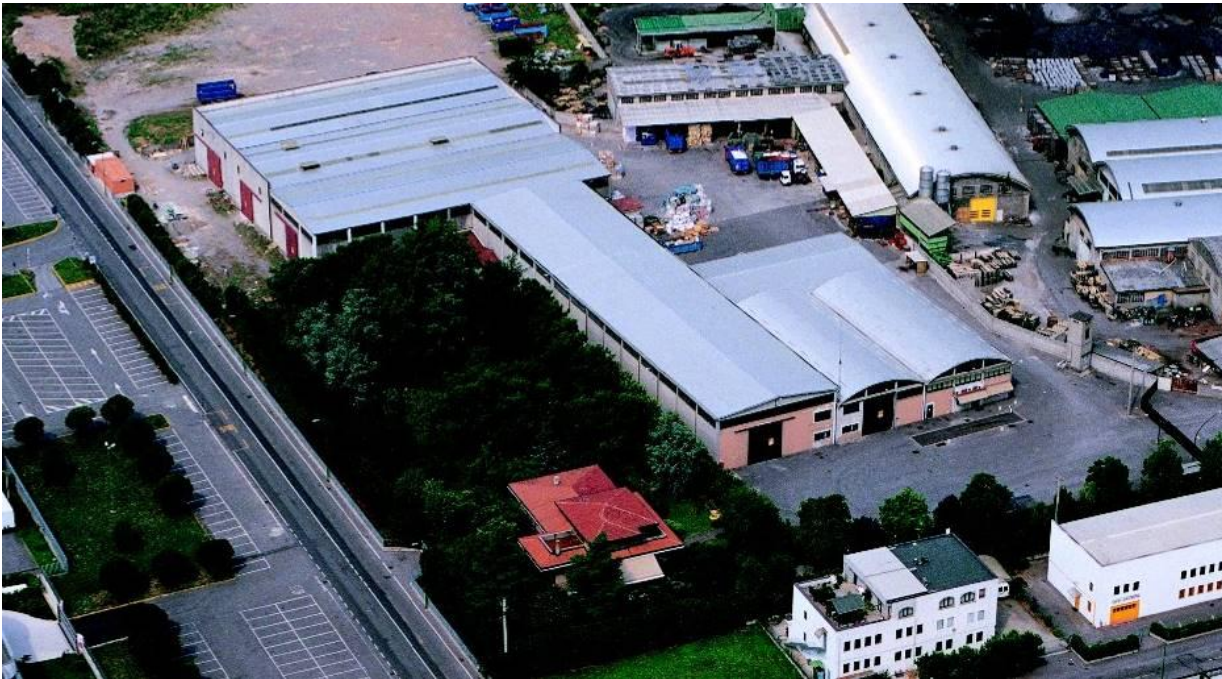
Fig. 2.1 – Fotografia aerea dell'impianto
